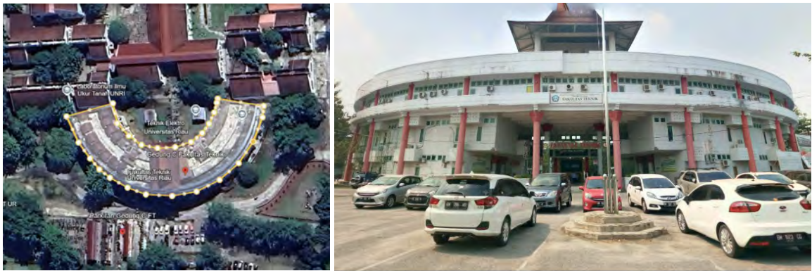
Gambar 1. Gedung C Fakultas Teknik Universitas Riau Sumber: Dokumentasi pribadi
