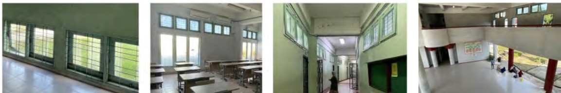
Gambar 5. Ventilasi pada bangunan Sumber: Dokumentasi pribadi
